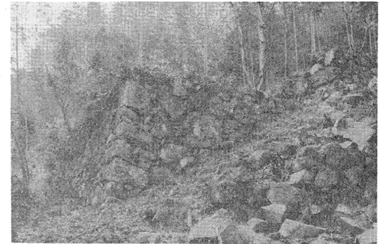
後藤地区の碁盤目状地割石垣
